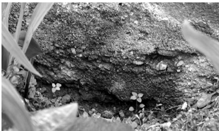
Dėl netvarkingos kanalizacijos atsirado juodos dėmės ant pamatų, dėl ko, pasak G. Vižingaitės, namo dalis gali ir sugriūti.
